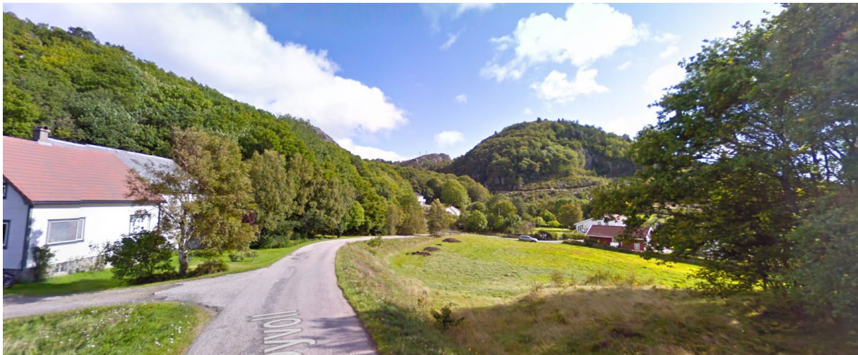
Figur 10 Illustrerer kommunal vei som er registrert med fartsgrense 80 km/t. Veien har nå en bredde på 4,5m.
