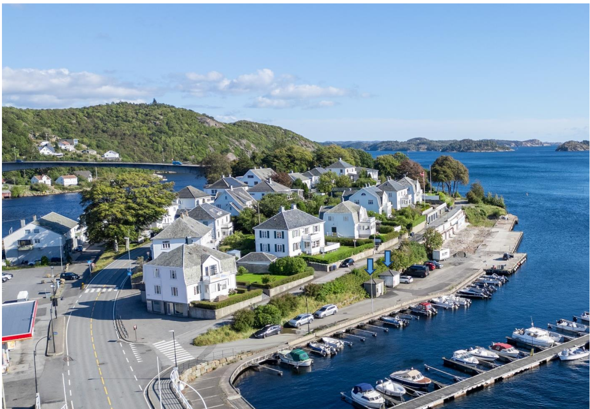
Figur 3 Oversiktsbilde av aktuelt område. Blå piler viser eksisterende trafo og pumpehus/stasjon.
