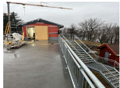
Varbak høydebasseng - Ferdigstilling av overbygg, sommer 2025
